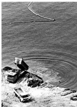
Camion per l'interramento
