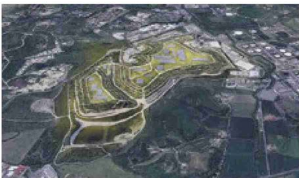
Il sito della discarica di Malagrotta a Roma.
