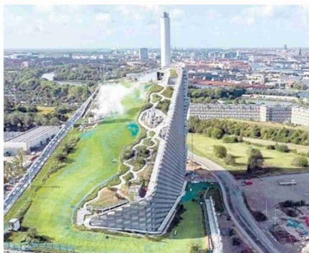
Il termovalorizzatore di Copenhagen realizzato nel 2013 con pista da sci sul tetto
