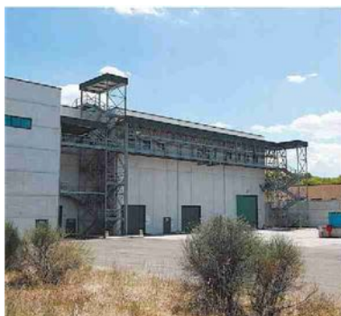
Inviolata L'impianto di trattamento meccanico biologico dei rifiuti urbani di Guidonia Montecelio
