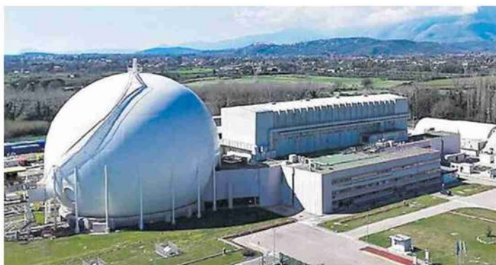
La centrale del Garigliano
