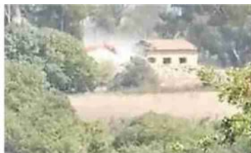
La demolizione del casale
